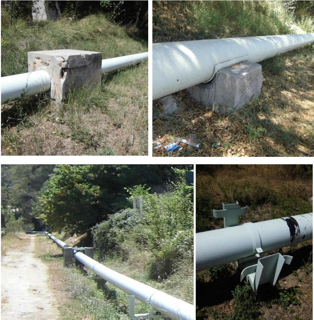
**Figure 3 : Différents dispositifs de soutènement de la canalisation aérienne**
